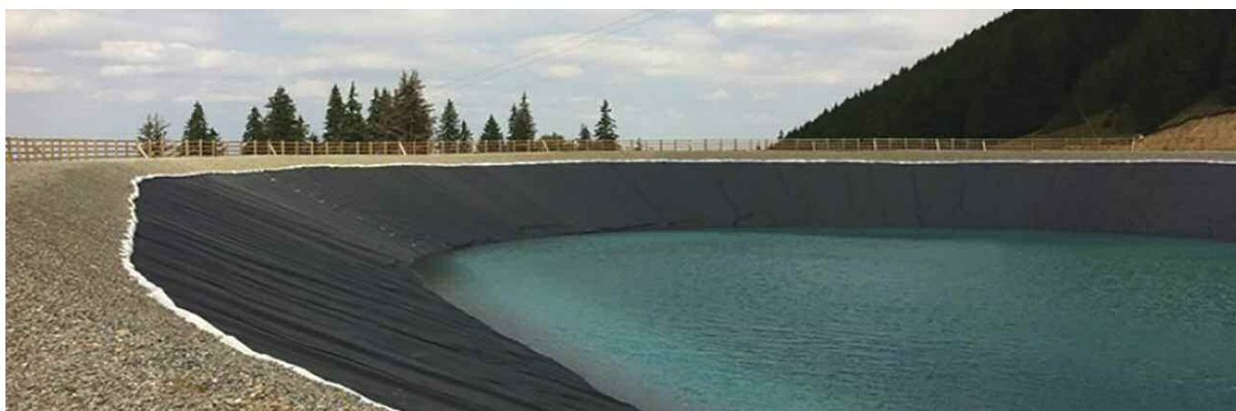
Impermeabilizare și montaj materiale geosintetice lac acumulare Ruia, Poiana Brașov, jud. Brașov
